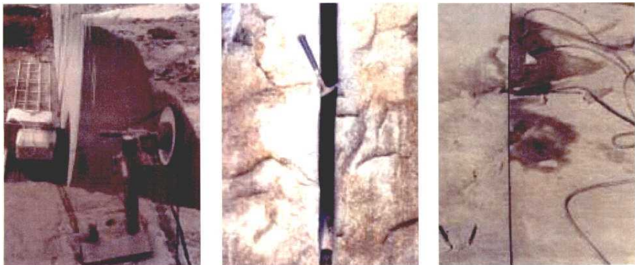
Fotografía 3.10.3. Corte en cantera con hilo diamantado y detalles del corte con lanza térmica e hilo.
