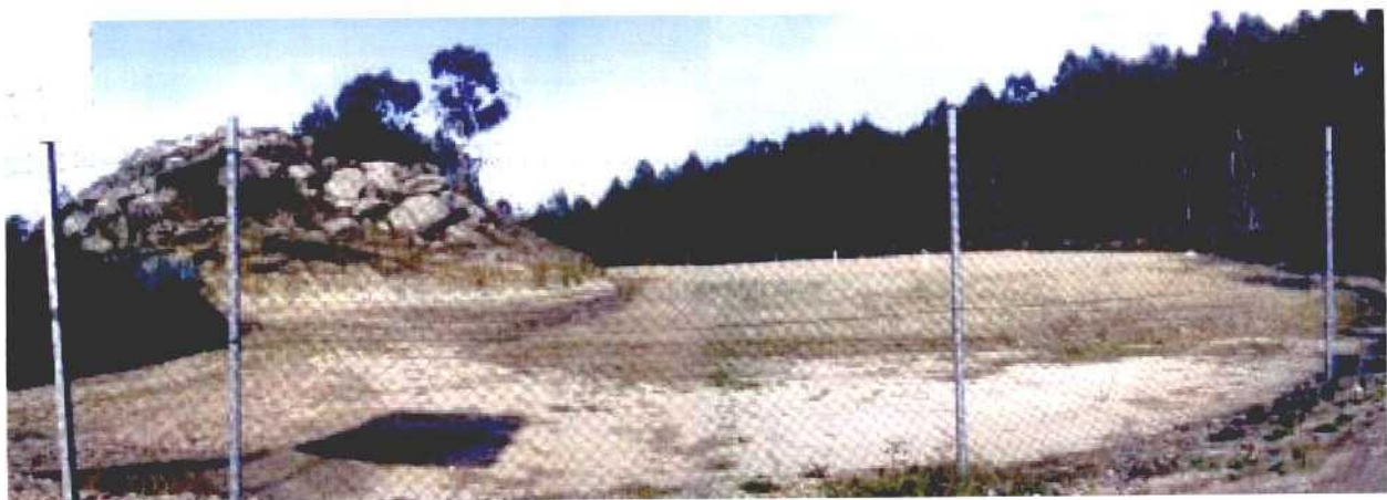
Fotografía 5.3 Buena práctica de relleno controlado en una cantera abandonada (N_R: 27698).
