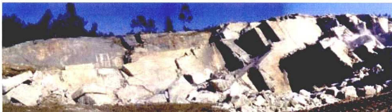
Fotografía 3.10.15. Aspecto del frente de explotación en la cantera N_2: 135, en granitos de dos micas cataclásticos del Macizo de Pedrada
