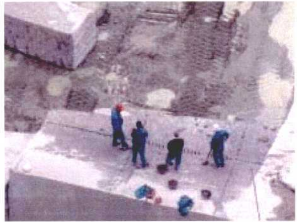
Fotografía 3.10.4. Subdivisión del bloque primario utilizando perforación y cuñas accionadas manualmente con mazos
