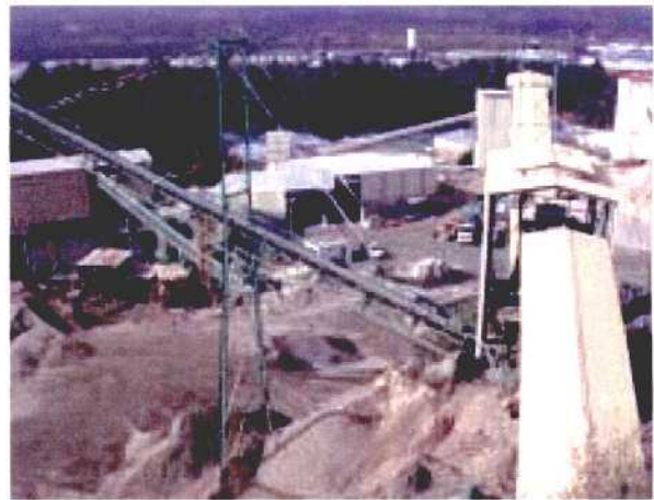
Fotografía 3.10.30. Vista parcial de una de las plantas de tratamiento de áridos de machaqueo a partir de rechazos de granito "Rosa Porrino".
