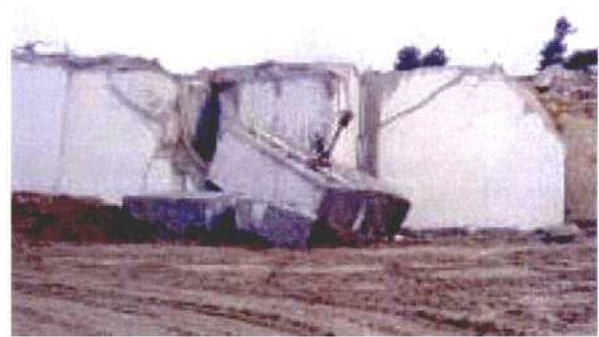
Fotografía 3.10.19. Carro perforador sobre un gran bloque primario en la cantera N_2: 23. Macizo de Caldasde Reis.
