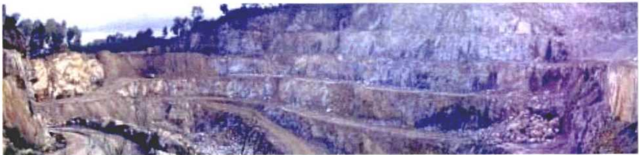
Fotografía 3.10.16. Aspecto general de la cantera N_2: 35, de áridos de machaqueo en granitos de dos micas.
