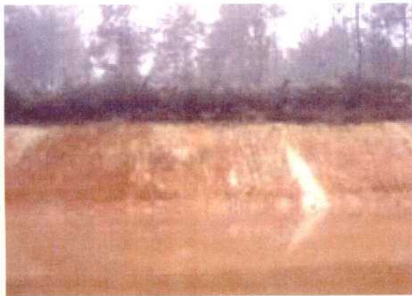
Fotografía 3.3.5. Aspecto del frente de extracción en la Estación 100.
