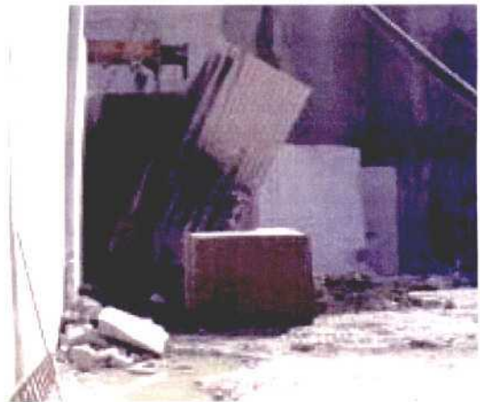
Fotografía 3.10.5. Volcado de un gran bloque sobre "cama" de tierra para evitar roturas.
