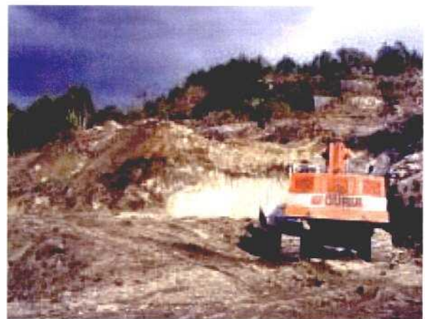
Fotografía 3.10.1. Eliminación del recubrimiento utilizando una retroexcavadora sobre cadenas.
