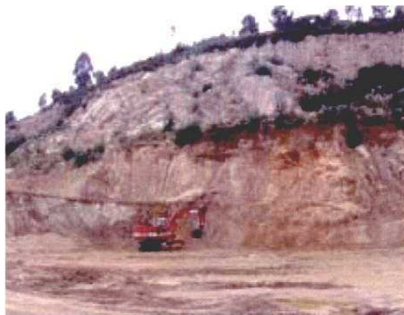
Fotografía 3.4.6. Vista parcial del frente de explotación de jabre en la cantera N_2: 49.
