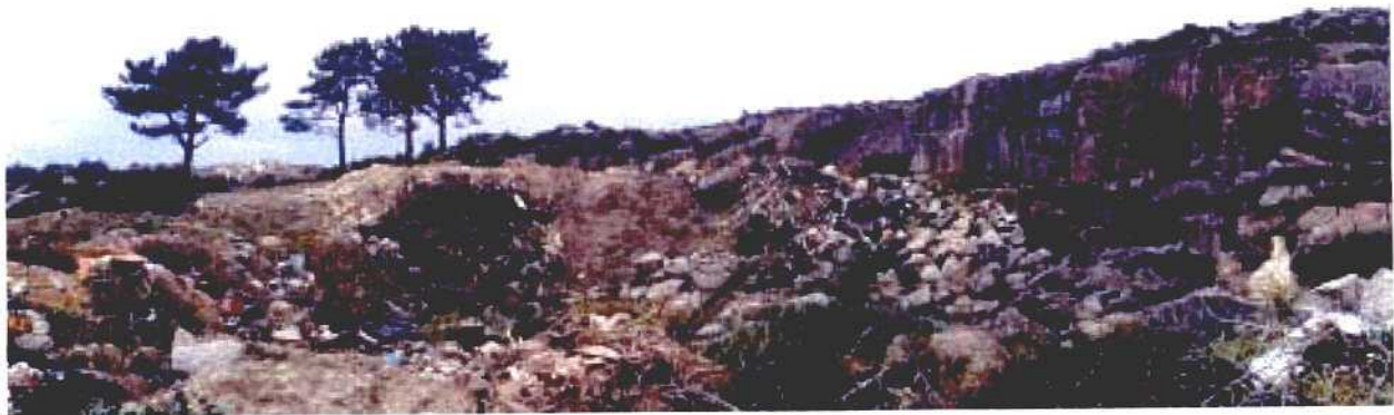
Fotografía 5.2 Mala práctica de relleno incontrolado en una cantera abandonada (N_R: 27619).
